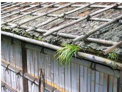
*Japanisches Haus: das Reisig des Daches mit Bambusstangen befestigt, Bambusstreifen als Wände*
